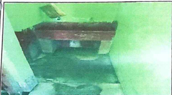
Foto 5: Sustrucción de grifos (4)
